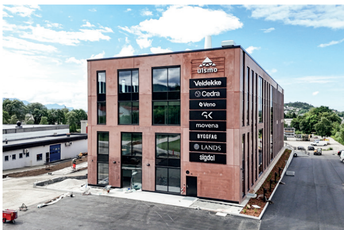
Holsletta 2C sett fra hjørnet i nordøst. Fasaden er eksponerte prefab-rikkerte betongelementer ferdig kjernefarget fra fabrikk, og vinduer og glassfasader fra H-fasader.
